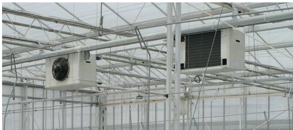
Figuur 15. Foto van twee van de zes koelers in de SunergieKas. De linker koeler toont de blaas-zijde en de rechterkoeler toont het warmtewisselaar oppervlak aan de zuigzijde. De koelers hangen op 6.5 meter hoogte.
